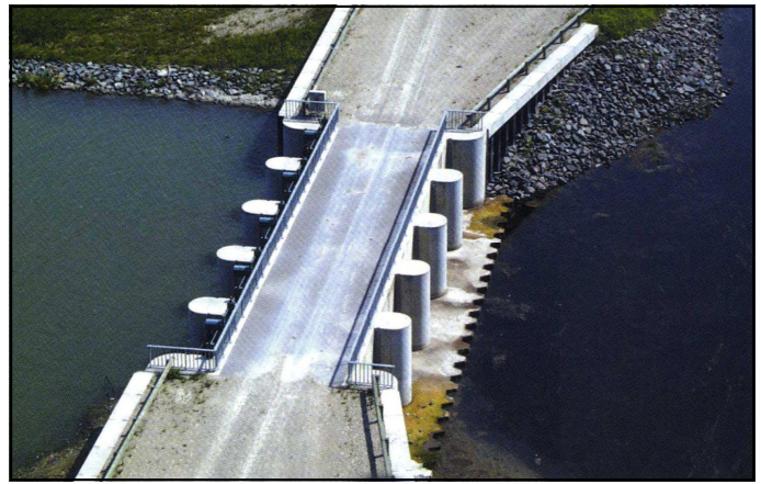
Ouvrage de vidange par surverse dans le plan d'eau de Plobsheim.
