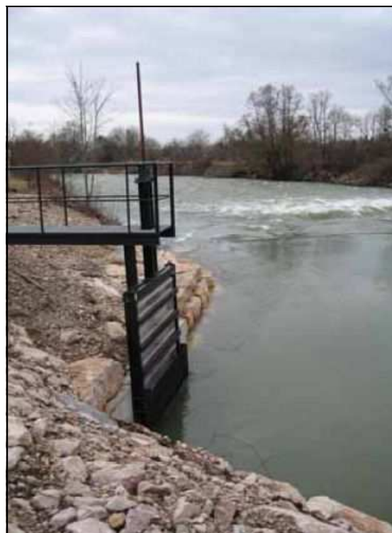
Prise d'eau sur la Loue alimentant la Morte des Fontaines
