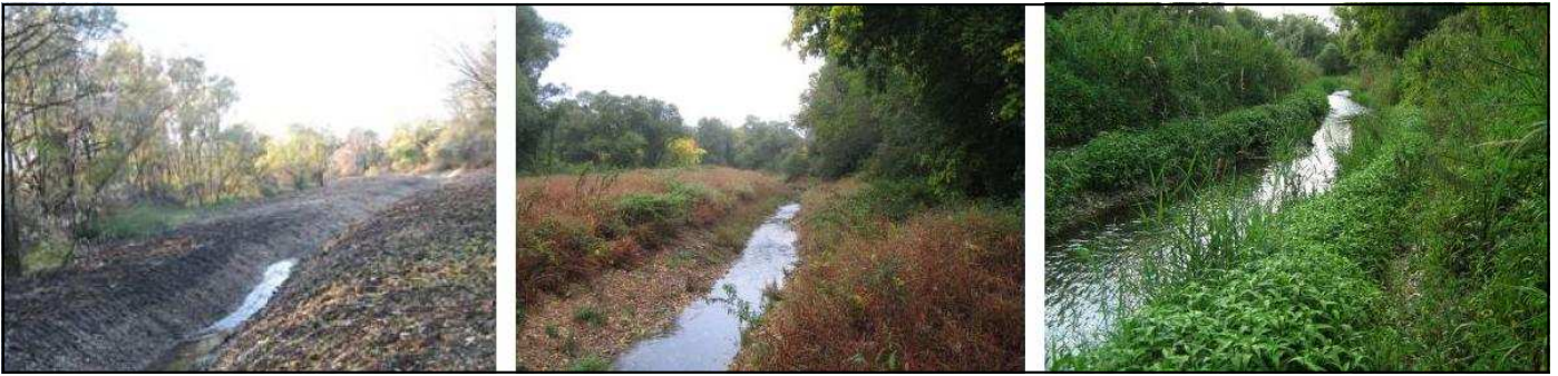
La Morte des Fontaines après restauration en 2007, 2008 et 2009. (Source Cabinet REILE)
