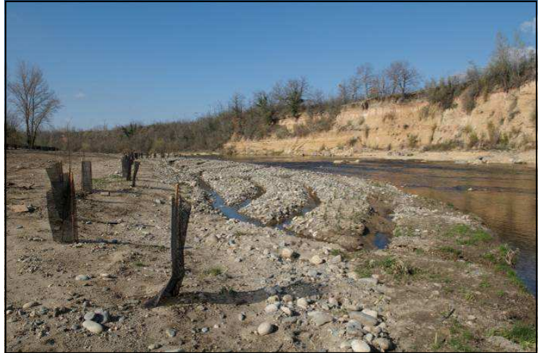
Travaux de modelage et de plantation de la partie inférieure du banc de gravier (Source SMEAG)
