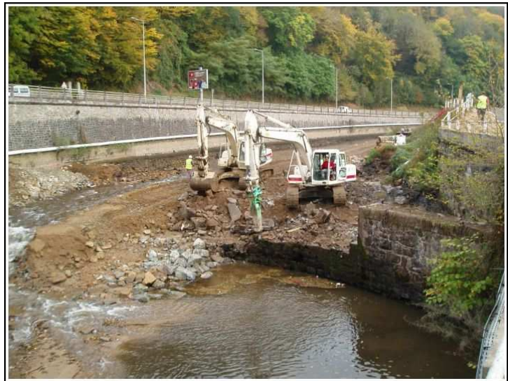
Travaux d'arasement du seuil de l'Usine BWA.
