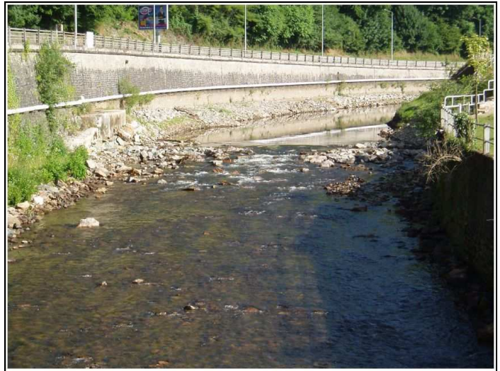
Le site du seuil de l'Usine BWA après arasement. (Source CC Tulle Cœur de Corrèze)
