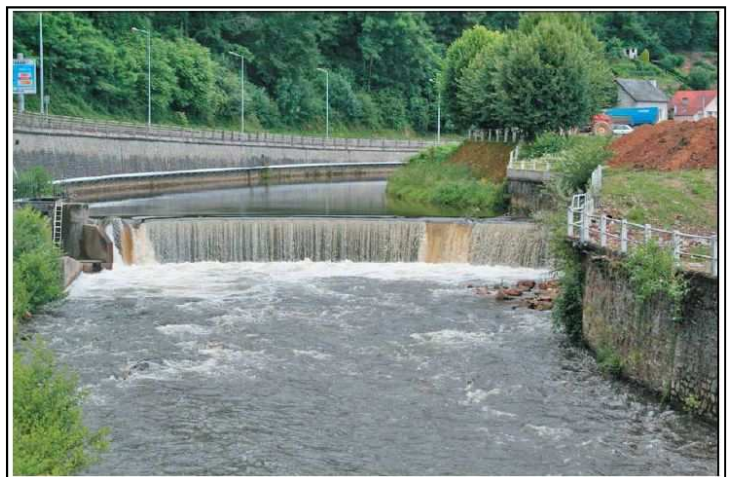
Seuil de l'Usine BWA avant arasement.
