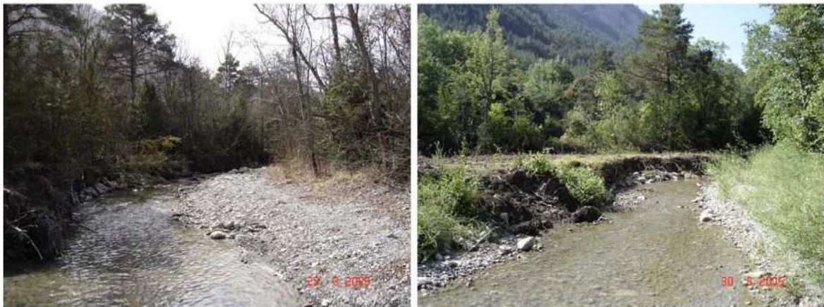
Terrasse alluviale de la Béoux avant et après déboisement.
